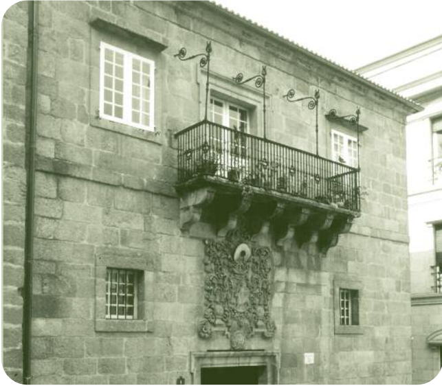
FACHADA DO EDIFICIO Á PRAZA MAIOR
