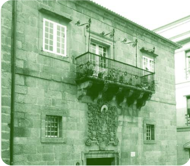
FACHADA DO EDIFICIO Á PRAZA MAIOR
