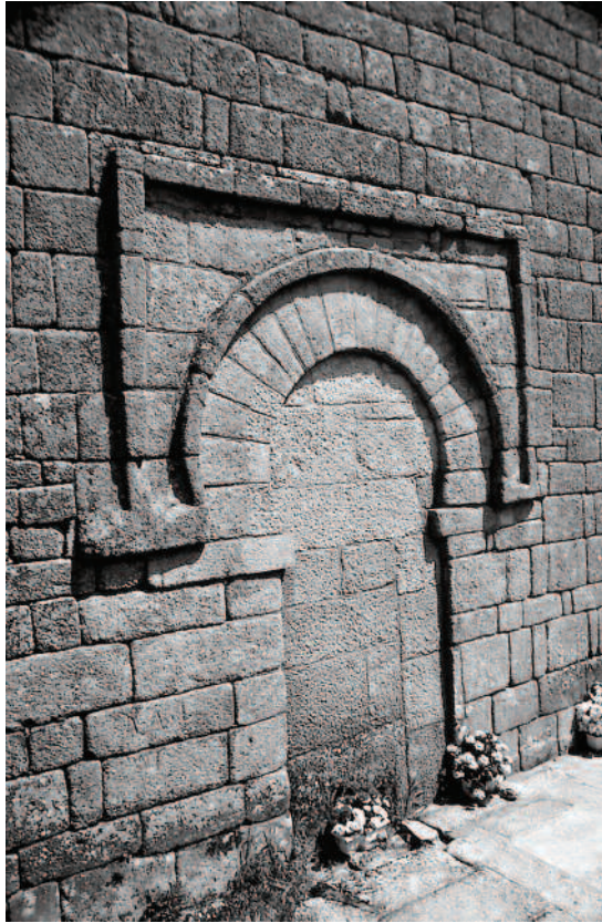
PORTA NA FACHADA SUR
